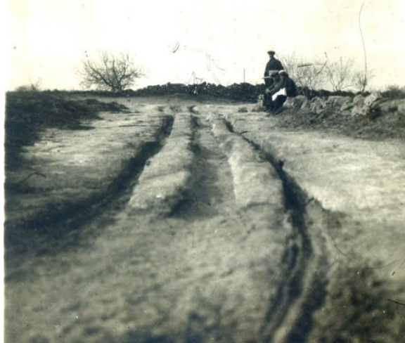
Fotoğraf 4. Bakü civarında - Hazar Denizi kıyısındaki eski araba yolları (Nardaran köyü)
